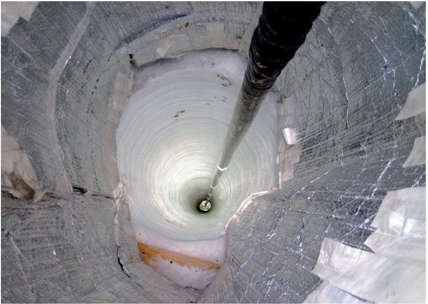
Posizionamento dei sensori DOM (Digital Optical Module) all'interno del rivelatore per neutrini IceCube, la cui costruzione è stata completata al Polo Sud nel dicembre del 2010 (foto NSF/B. Gudbjartsson). Il telescopio, delle dimensioni di 1 km 3 , è formato da 86 stringhe per un totale di 5.160 moduli ottici che catturano i segnali lasciati dal passaggio di neutrini ed è lungo 2.820 metri, circa nove volte la Torre Eiffel.
